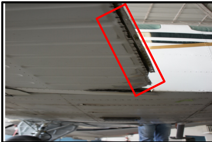
Fotografía No. 11 Daños en el flap izquierdo.
